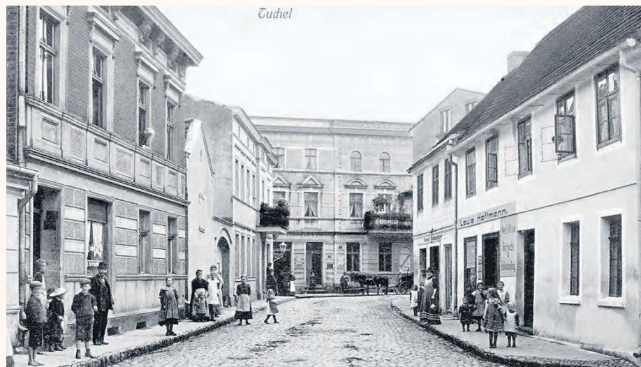
Ulica Chojnicka – na wprost kamienica, w której mieściła się restauracja „U Szulcowej”.
