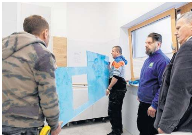
W pokoju kąpielowym niedawno zostały zamocowane szklane tafle przypominające morskie fale
