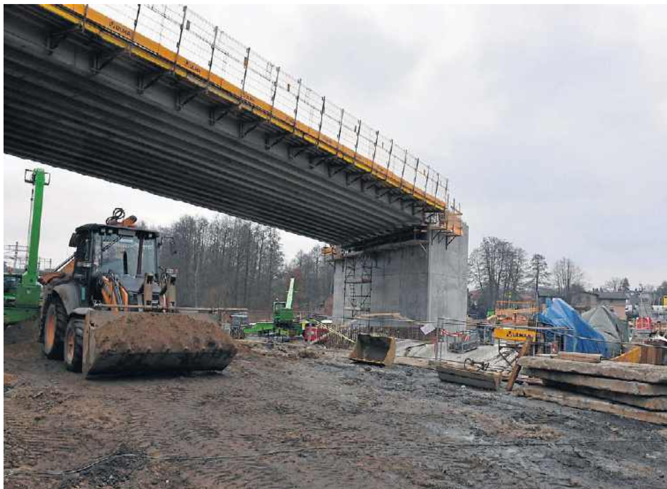
Budowa wiaduktu drogowego na ulicy Dworcowej w Żorach, nad linią kolejową Pszczyna - Żory
