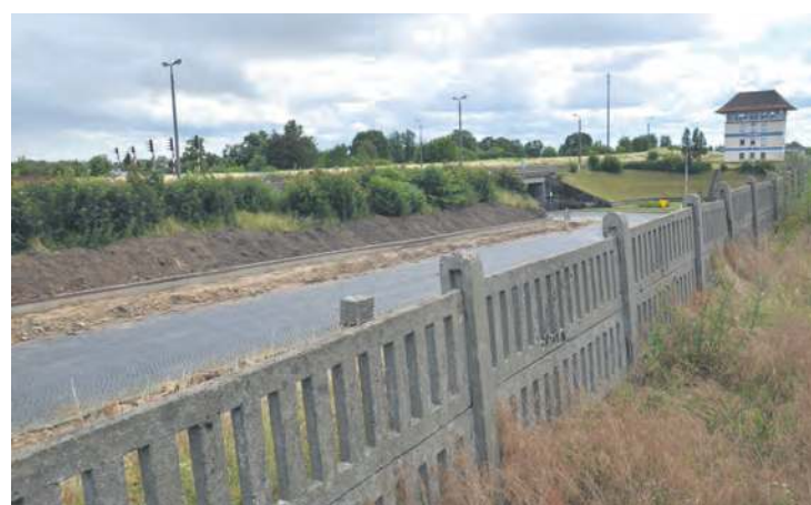
Całkiem możliwe, że ogrodzenie z betonu zostanie rozebrane.
