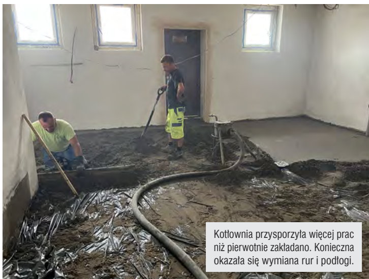
Prace przy ociepleniu na części ukończonej przez BOK i OSP.
