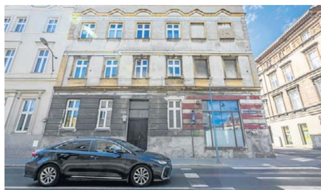
Elewacja kamienicy u zbiegu ulic Podgórnej i Wierzbickiego ma zostać wkrótce odnowiona
