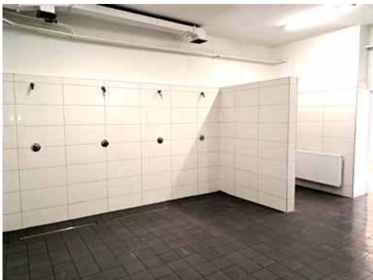
W ramach inwestycji w SP nr 11 całkowicie wymieniona została m.in. instalacja wodno-kanalizacyjna i elektryczna
