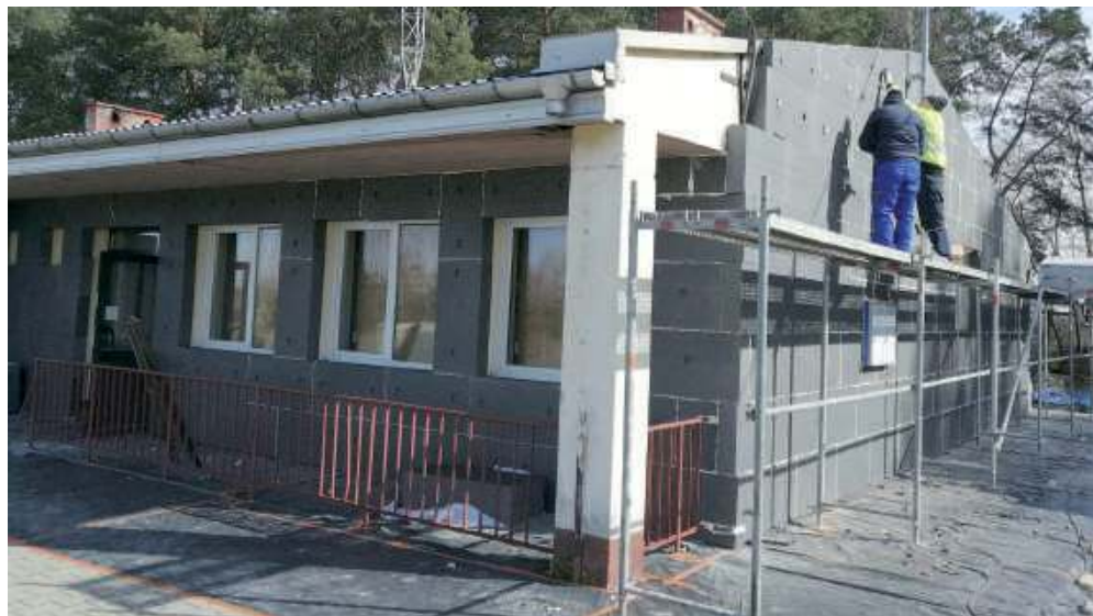
Prace budowlane przy nowej elewacji domu ludowego w Ostrówkach
