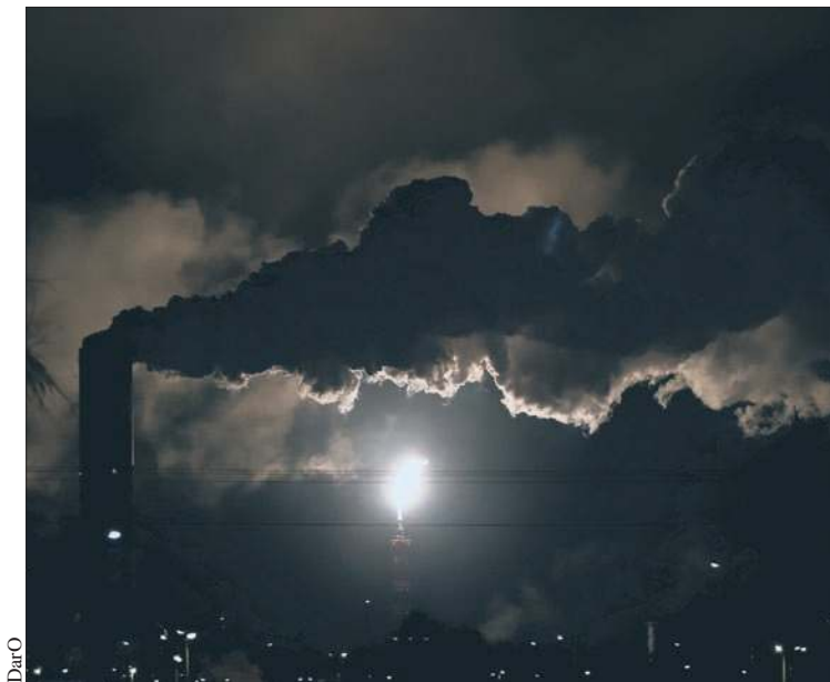
Wysoki płomień pochodni i kłęby pary zaniepokoiły płocczan
