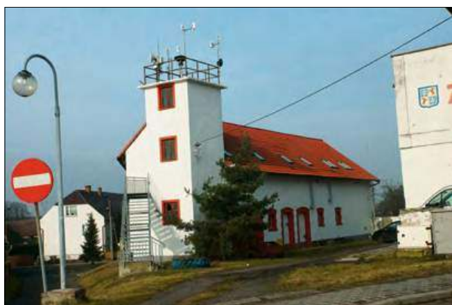
Z ekspertyzy wynika, że urządzenia instalacji radiowego systemu alarmowania w remizie OSP w Żyrowej nie nadają się do naprawy z uwagi na przestarzałą technologię.
