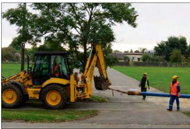
Prace przy wymianie magistrali prowadzone są obecnie pod deptakiem przy placu Eichendorffa.
