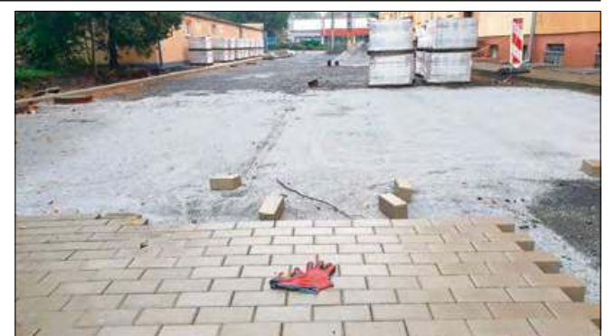
Prace budowlane na osiedlu 1000-lecia znowu stanęły.
