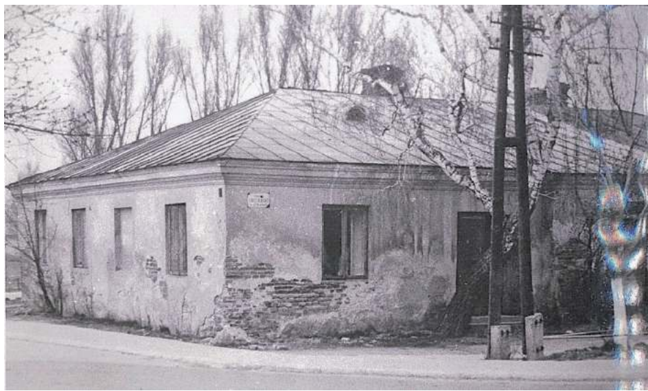
Dawny zajazd w Czemiernikach, stan z 1973 roku (foto archiwalne: W. Koziejowski i W. Głodzik)
