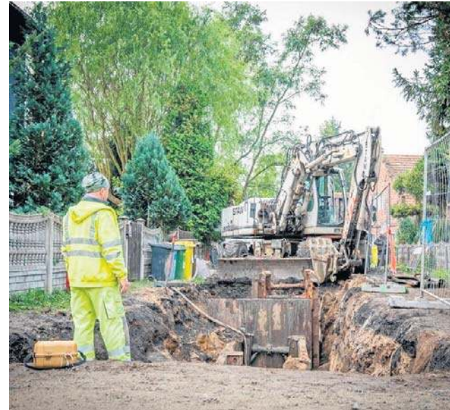
MPWiK Wrocław otrzymało największe dofinansowanie w swojej historii: ponad 286 mln zł - na budowę nowych sieci i rozbudowę oczyszczalni „Janówek”
