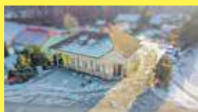
Budynek handlowo-usługowy w Misiach, 4 kilometry od obwodnicy Międzyrzecza Podlaskiego, 669 494 058
