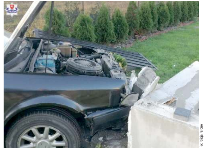
Auto uderzając z impetem w betonową podmurówkę ogrodzenia uszkodziło dwa metalowe przesła o długości 8 metrów
