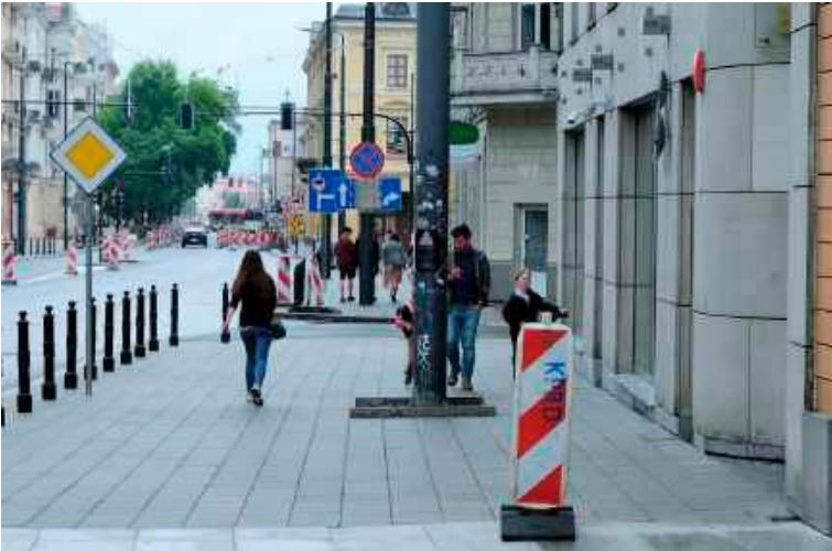
Urzędnicy tłumaczą, że nie dało się inaczej, a słupy na środku chodnika, choć oprócz przechodniów poruszają się po nim hulajnogi, nie stwarzają niebezpieczeństwa
