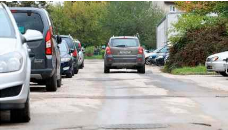
Przetarg na remont ulicy Witosa ma zostać ogłoszony w dniach. To jednak nie jedyna inwestycja drogowa, którą miasto planuje w tym roku na osiedlu Wschód
