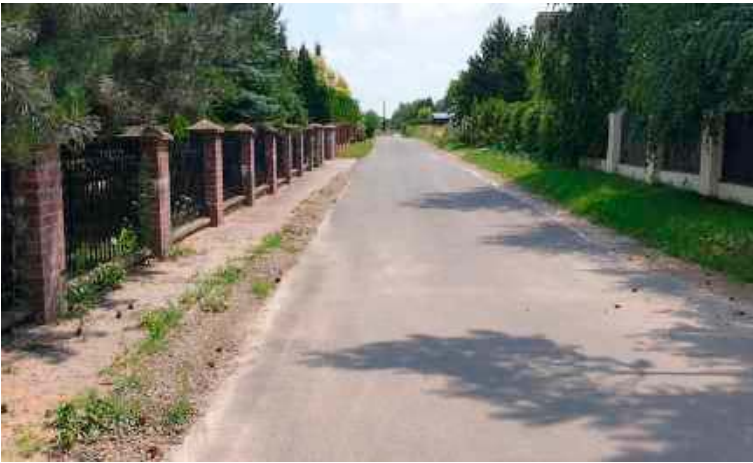
Ulica Łazurowa – jedna z wyremontowanych gruntówek, na której w ubiegły czwartek odbyła się konferencja podsumowująca dotychczasowe efekty programu naprawy świdnickich gruntówek
