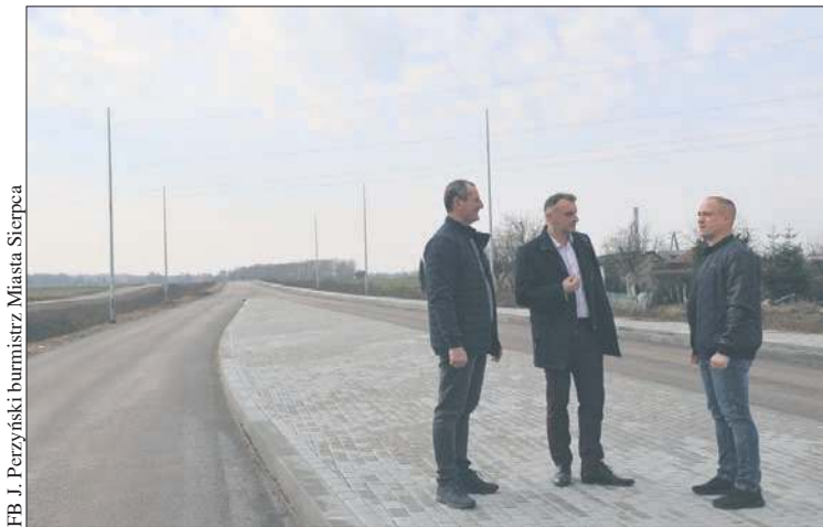
Sierpecka obwodnica ma być gotowa na koniec I półrocza bieżącego roku. Koszt budowy 3 kilometrowego odcinka to kwota ponad 73 mln zł
