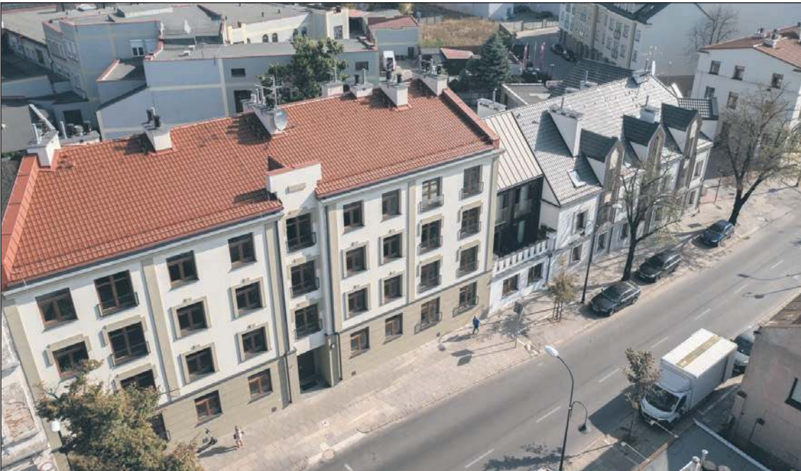
W tej części miasta powstało już kilka budynków z Mieszkaniem na start, m.in. przy ul. Sienkiewicza i Kaczmarskiego
