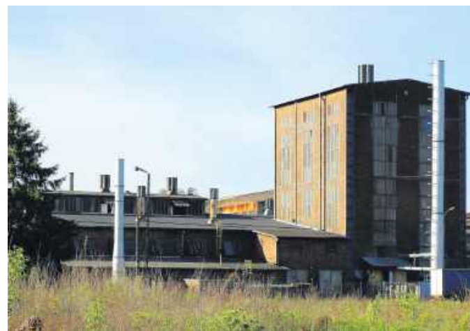
Hartownia z roku 1938. Wszystkie konstrukcje hal zakładów miały konstrukcję szkieletową – stalową, ażurową, wypełnianą ceglami lub szkłem, by w razie wybuchu czy eksplozji, siła rażenia uszkodziła minimum obiektu
