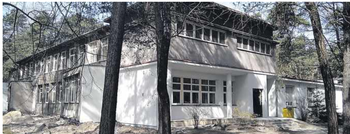
W tym budynku powstanie Centrum Opiekuńczo-Mieszkalne
