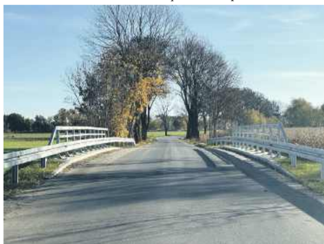
Inwestor wyremontował most. Wartość prac ok. 3 mln zł
