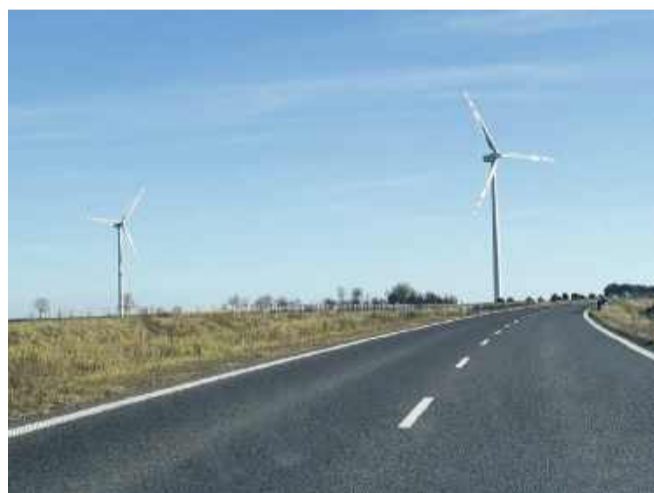
Turbiny już produkują energię
