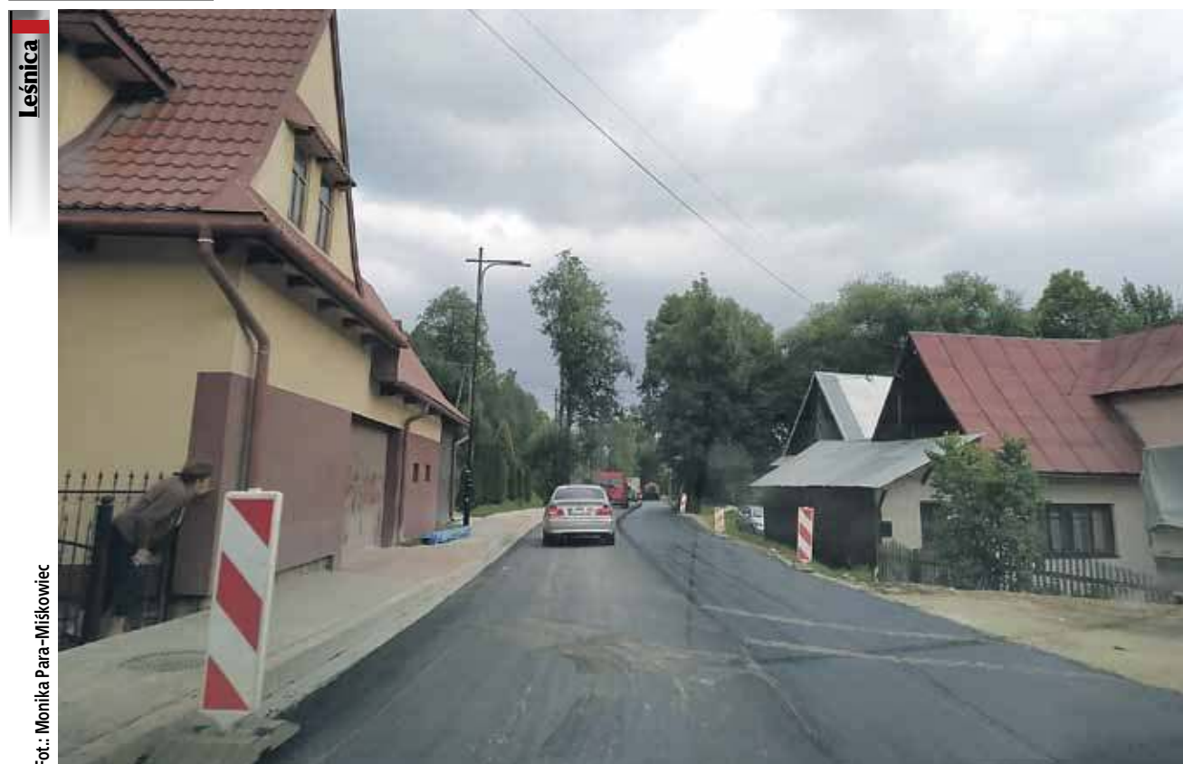
Mieszkańcy doczekali się na remont drogi głównej w Leśnicy. W piątek robotnicy kładli asfalt na odcinku od remizy w kierunku Bukowiny. W tym czasie wprowadzony był ruch wahadłowy. Inwestycję realizuje powiat tatrzański. Prace na drodze powiatowej prowadzone są też na Olczańskim Wierchu w Bukowinie Tatrzańskiej.
