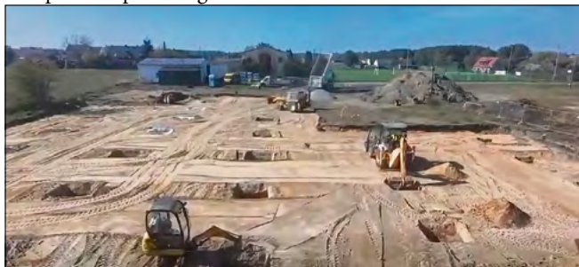
Trwają prace związane z budową nowoczesnego kompleksu sportowego Orlik w Bierdzanach.
