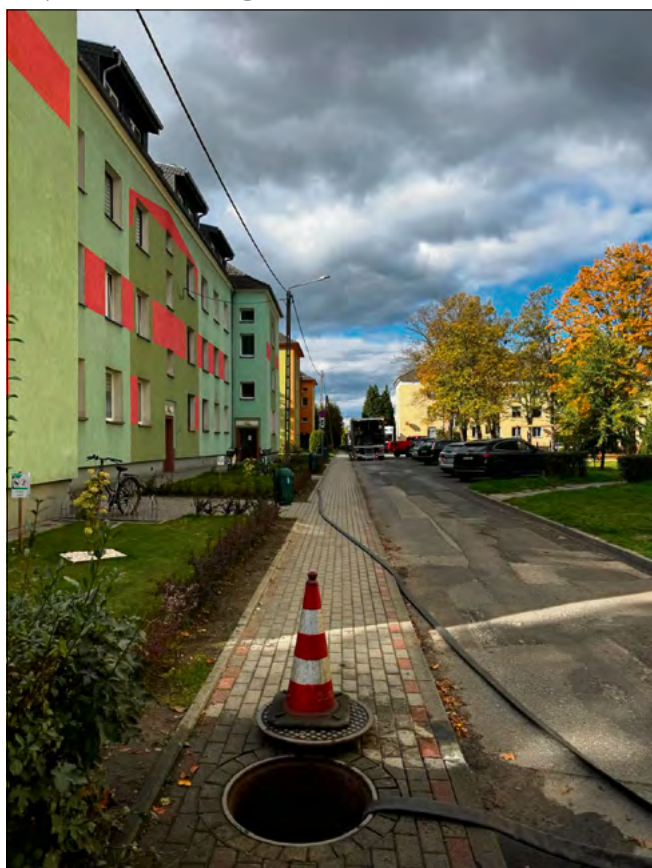
PGKiM w Antoniewie systematycznie modernizuje sieć kanalizacji sanitarnej.
