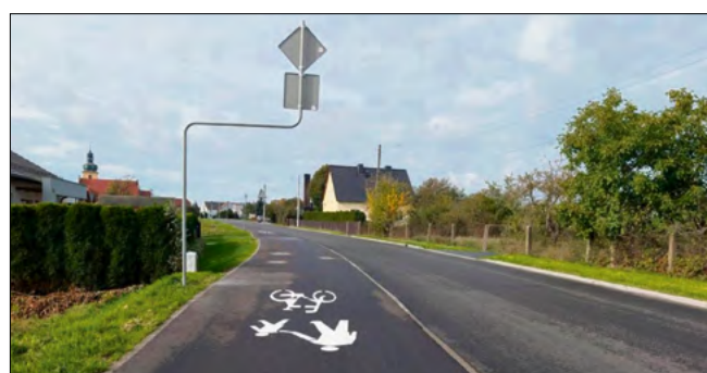
Ważnym elementem przebudowy ulicy Nakielskiej są przejścia dla pieszych.
