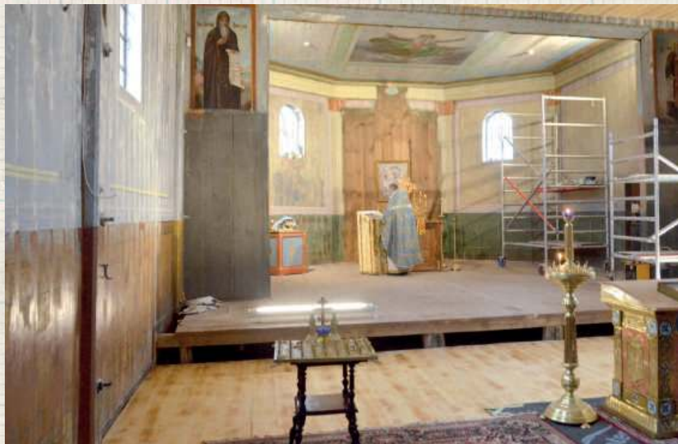
Przez kilkanaście miesięcy remontu wnętrza ksiądz proboszcz Tomasz Łotysz musiał odprawiać bez ikonostasu za to przy rusztowaniach budowlanych. Ale efekt przerósł oczekiwania
