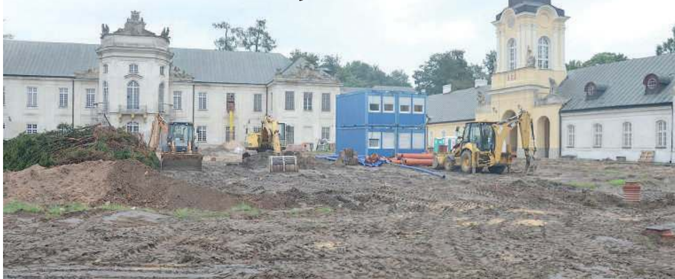
Na pałacowym dziedzińcu trwają prace rewitalizacyjne. Całość renowacji pochłonie w sumie 19 mln zł
