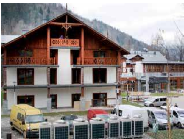
Trwają ostatnie prace wykończeniowe przy Hotel Szczawnica Park.
