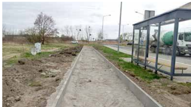
W ramach inwestycji przebudowana zostanie istniejąca już wiatka przystankowa
