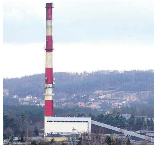
Ciepłownia przy Pogorskiej w Chrzanowie gdzie miała powstać spalarnia RDF-ów
