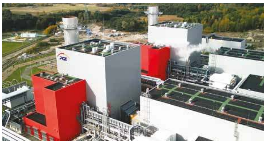
Elektrownia gazowa PGE Gryfino Dolna Odra
