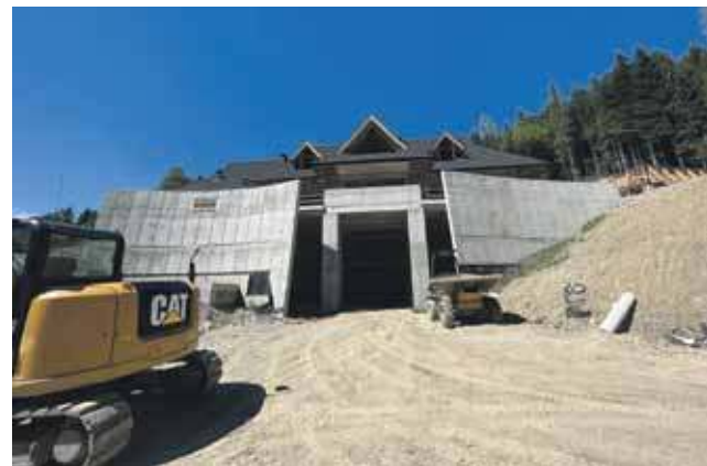
Znaczna część atrakcji przyszłego centrum edukacyjno-przyrodniczego została ukryta pod ziemią.
