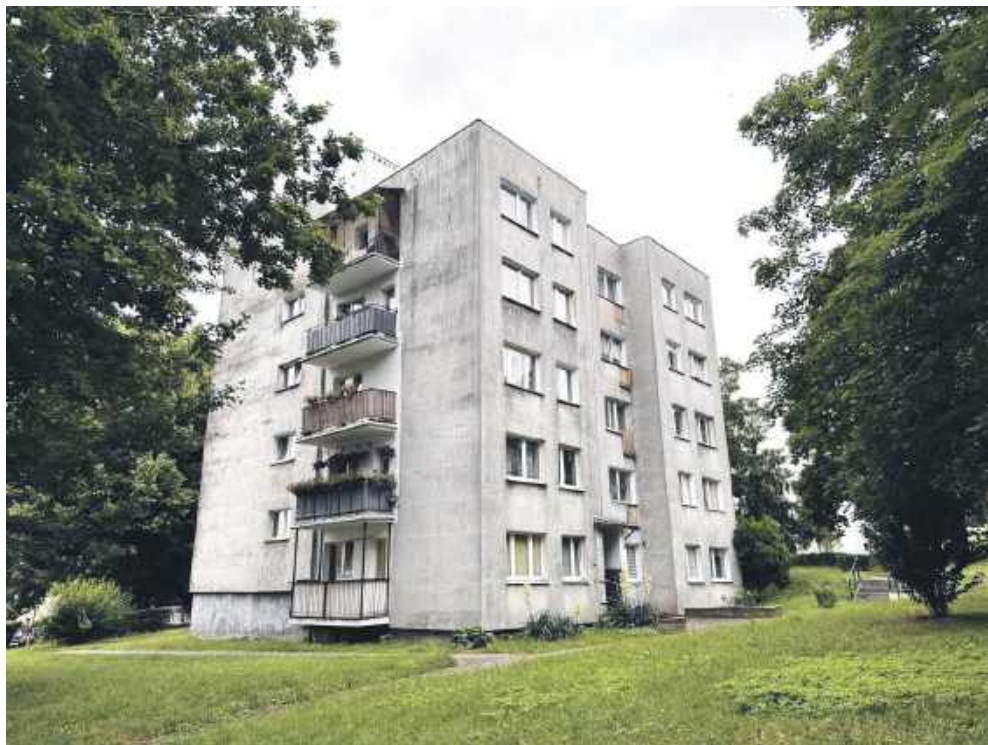
Cały blok został odcięty od gazu
