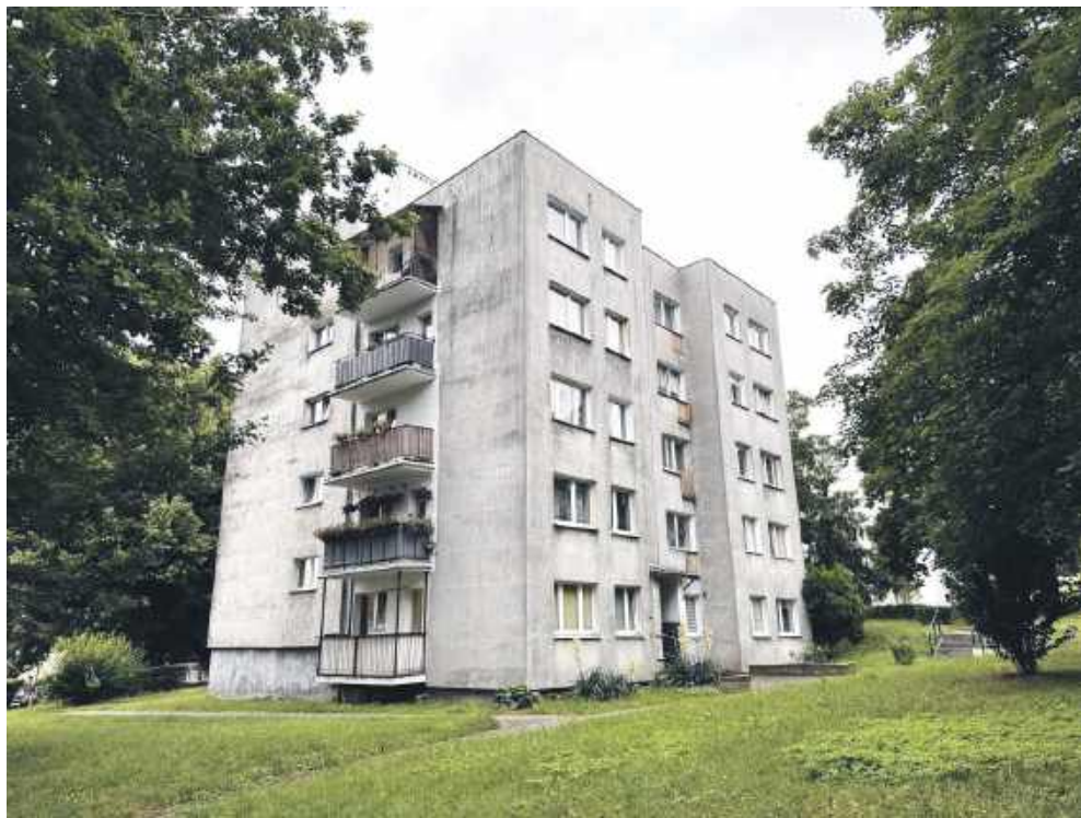
Cały blok został odcięty od gazu
