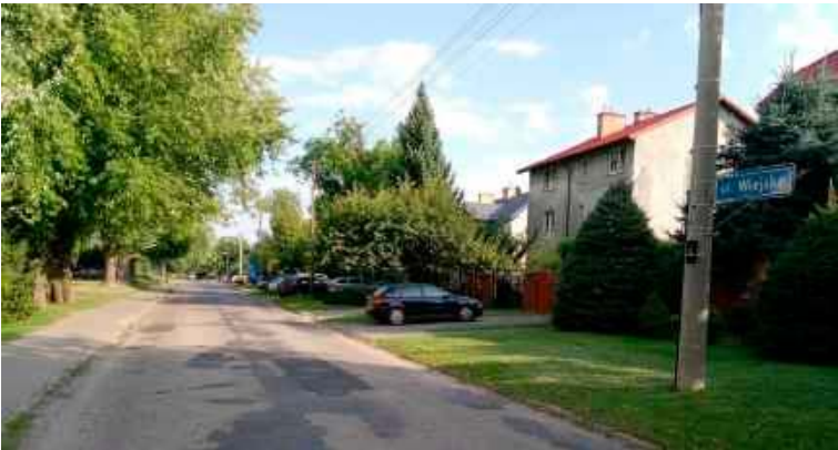
Ulica Wiejska kolejny rok poczeka na remont
