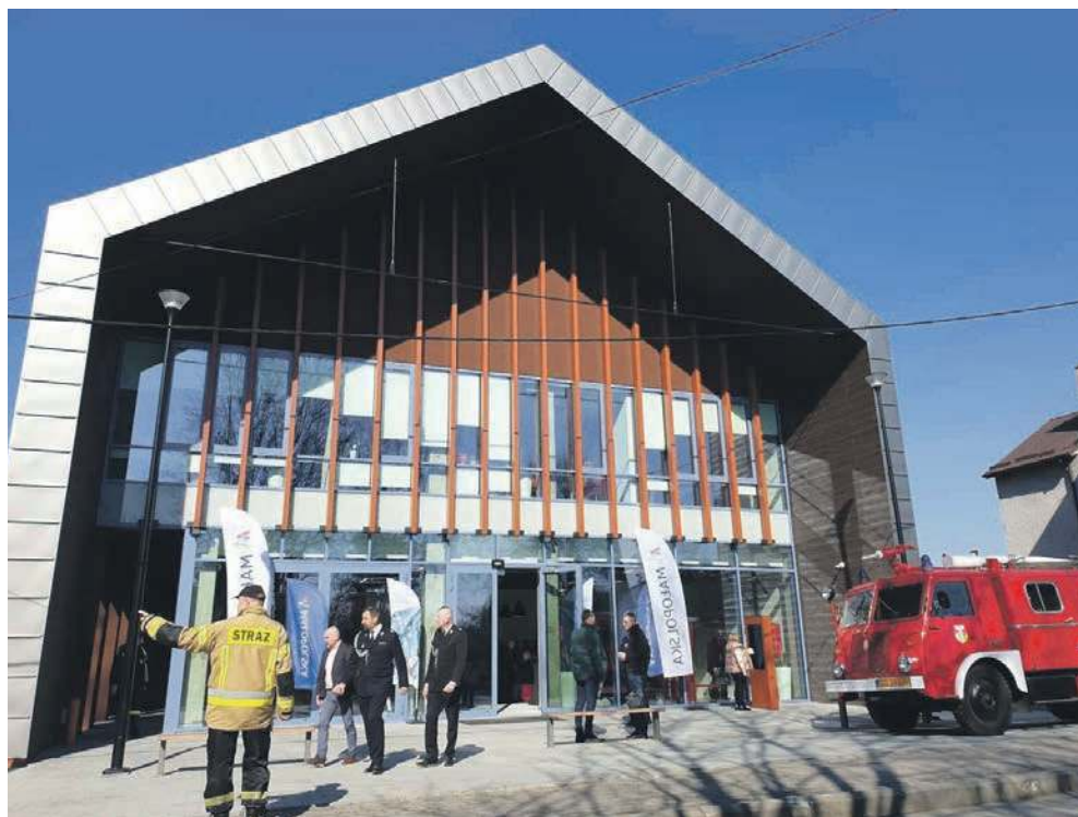
Budynek muzeum widoczny od strony głównego wejścia
