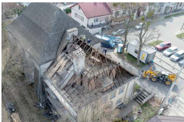
Stan budynku w trakcie prac rozbiórkowych pokrycia dachowego
