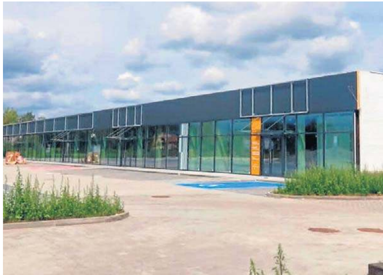
Budynek galerii handlowej Airpark w Kobylinie jest niemal gotowy.
