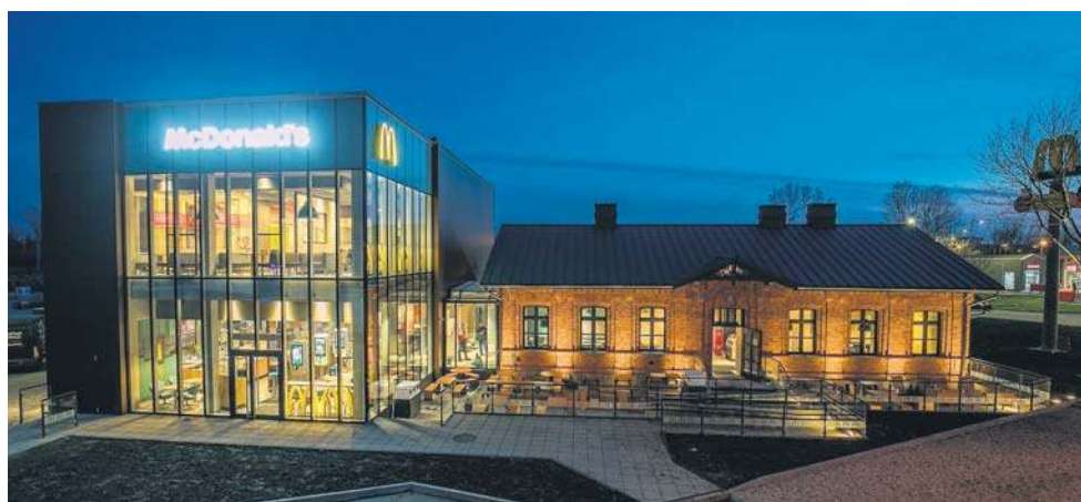
Restauracja McDonald's, ul. Radzymińska 94A w Warszawie
