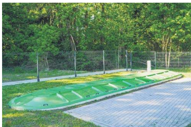
Budowa oczyszczalni ścieków w miejscowości Chwalimki
