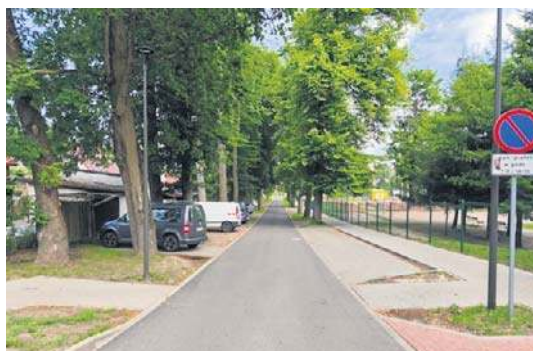
Wyremontowana ulica Szkolna
