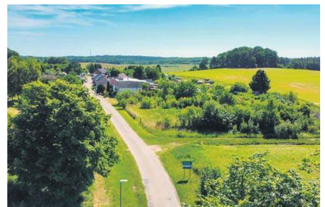
Przebudowa drogi do miejscowości Tarmno
