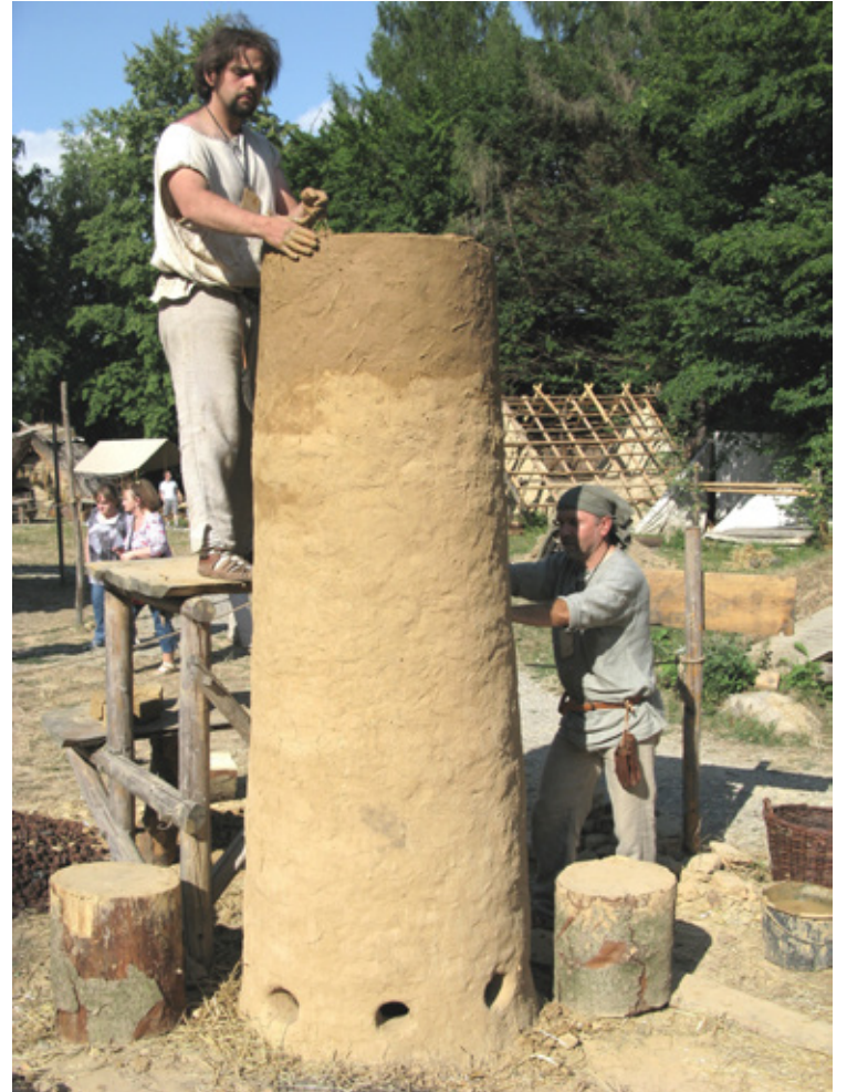
Rekonstrukcja pieca tarchalickiego na Dymarkach Świętokrzystkich w 2013 r. Fot. P. Madera
