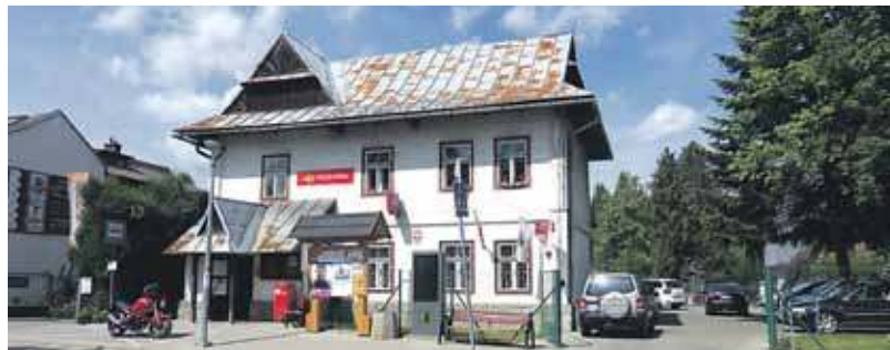
Niebawem ruszą prace rozbórkowe i stary budynek zastąpiony zostanie przez nowoczesny obiekt.
