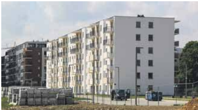
Blok przy ul. Sikorskiego, w którym znajdzie swe miejsce do życia 130 najemców.
