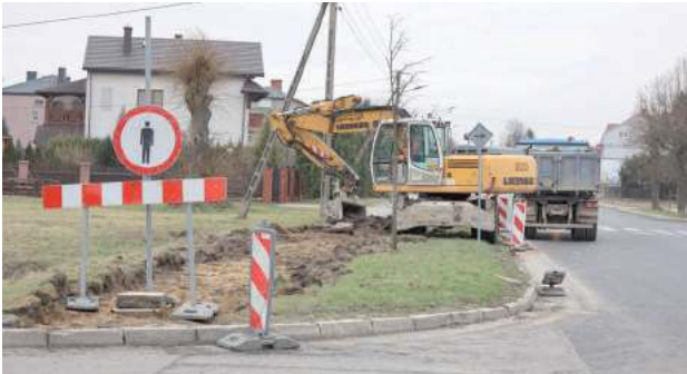
Remont chodnika przy ul. Kopernika
