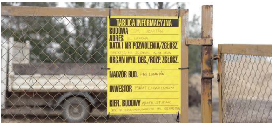
Rozpoczęła się budowa COM w Lubartowie
