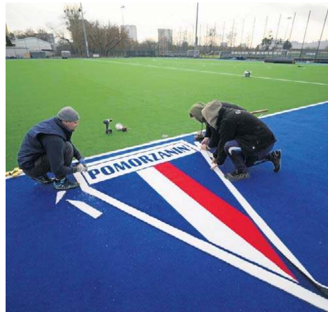
Na remont z prawdziwego zdarzenia czekali także toruńscy hokeiści na trawie
