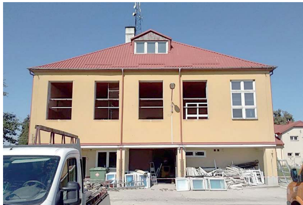
Remont Zespołu Szkół w Suchowoli, który potrwa rok, zaplanowano z uwzględnieniem rytmu zajęć szkolnych
