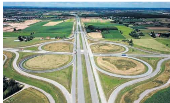
Droga zostanie zrealizowana w systemie „Projektuj i buduj”. Prace budowlane przewidziane są na lata 2022-2024
