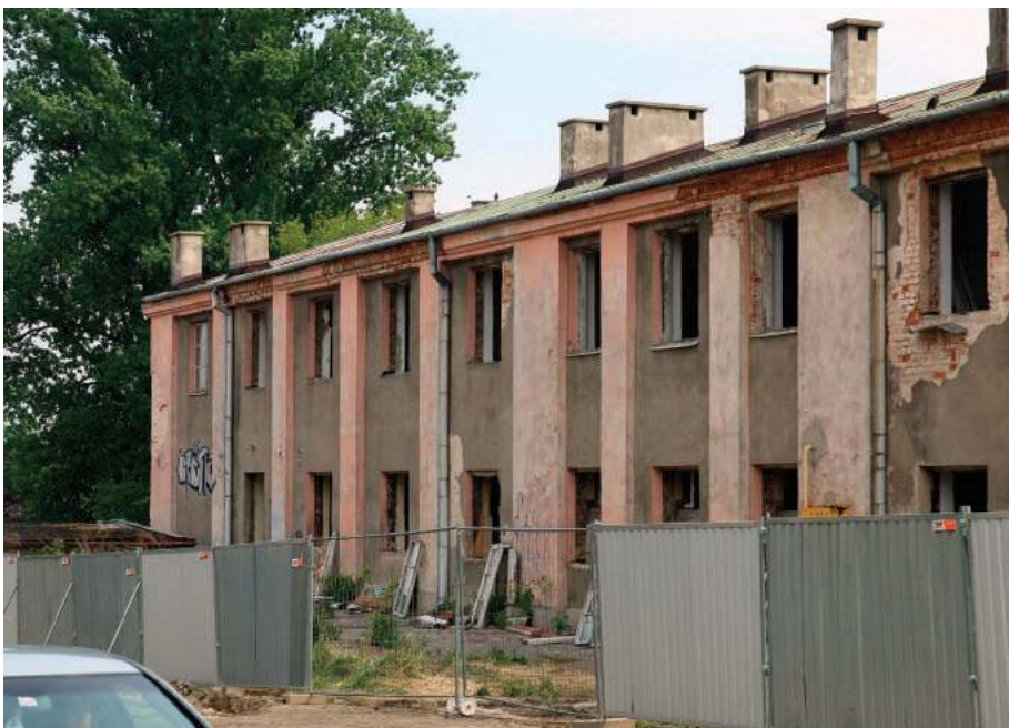
W ubiegłym tygodniu wybuchł również pożar w przeznaczonym do wyburzenia pustostanie, dawnej siedzibie studium wojskowego, u zbiegu Al. Raclawickich i ul. Poniatowskiego. Zginęło w nim dziesiątki gniazdujących na poddaszu ptaków. Przyczyną było prawdopodobnie celowe podpalenie. Prezydent Żuk skierował do prokuratury zawiadomienie o możliwości popełnienia przestępstwa
