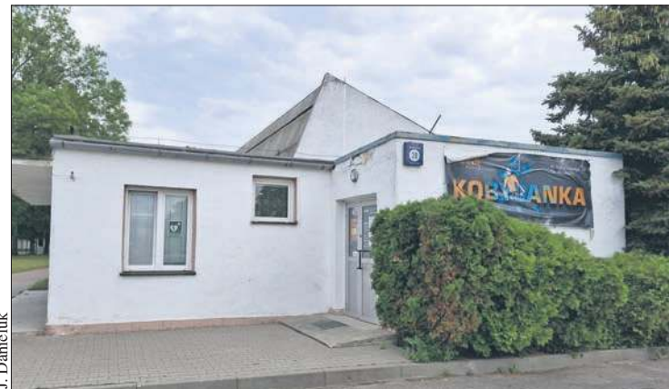
Pływalnia „Kobylanka” została zamknięta w ubiegłym tygodniu. Jeszcze w tym roku zostanie wyburzona. W jej miejscu powstanie parking
