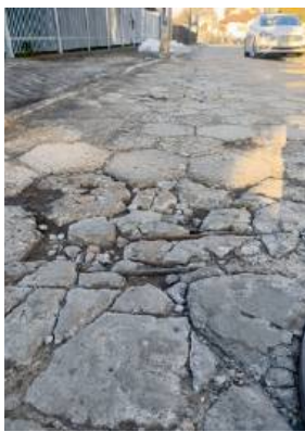
Ulica Fabryczna doczeka się nowej nawierzchni.
