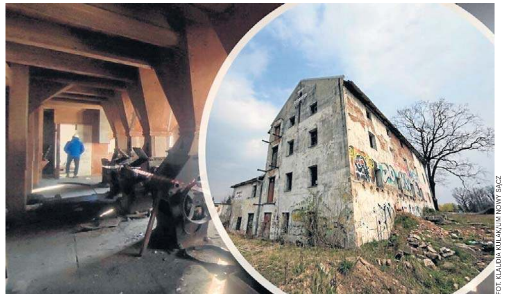
Taki wygląd młyna jezuickiego niebawem przejdzie do historii. Prace właśnie ruszyły
