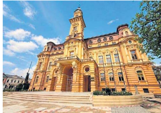
Nowe-stare wejście do ratusza bardziej eksponuje nowy kolor elewacji. Wróciła też zieleń, której brakowało
