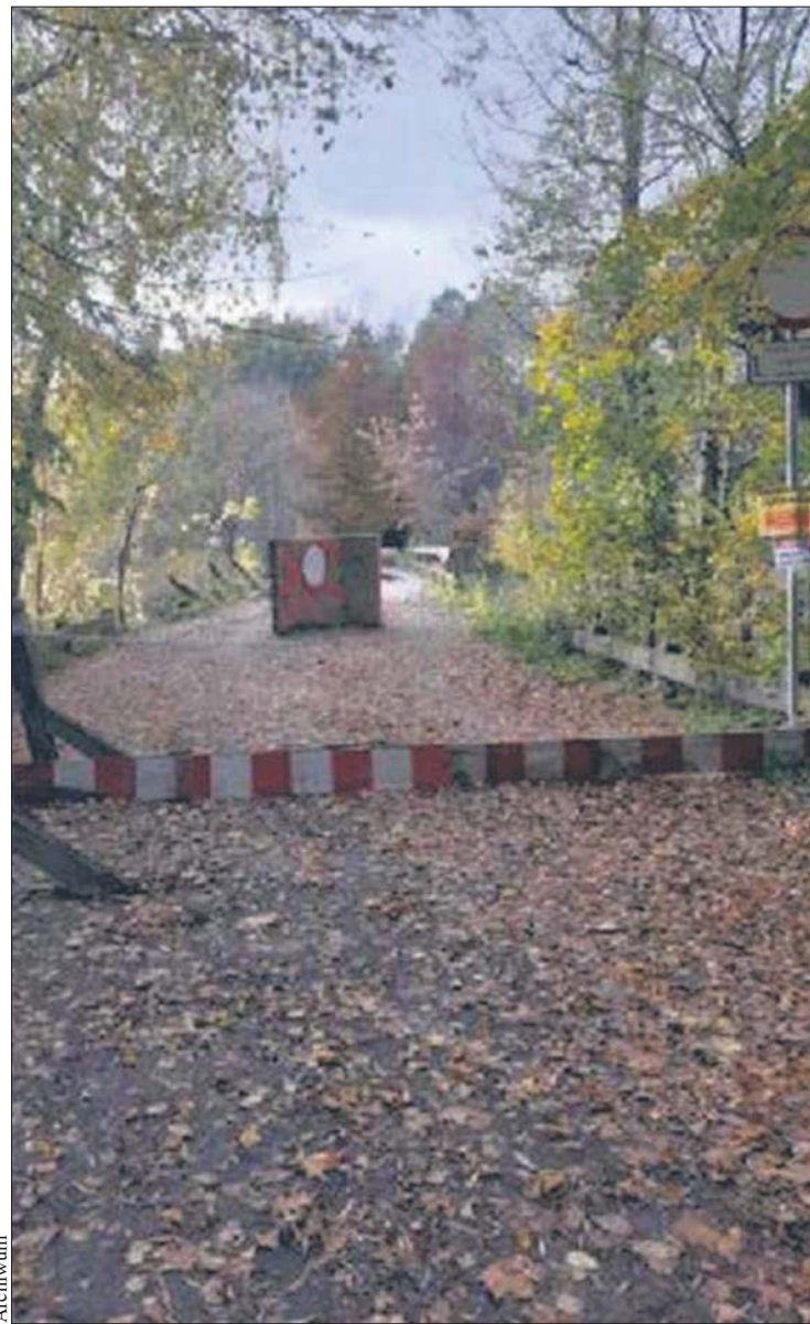
Od 2019 roku most na Skrwie jest zamknięty
