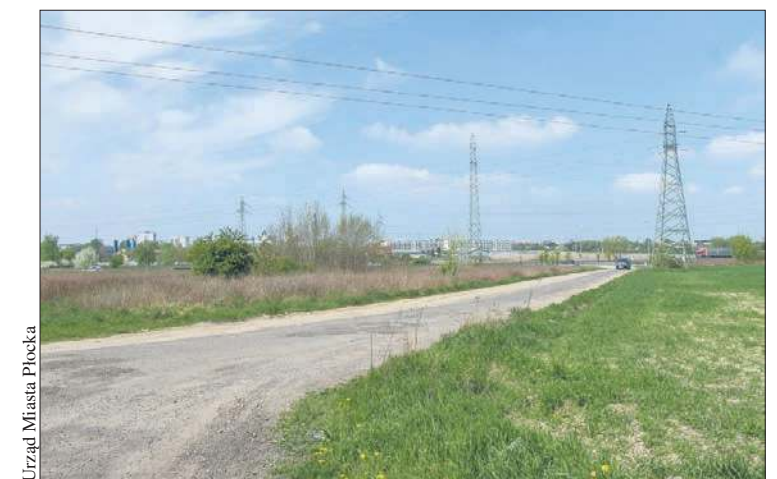
Przebudowa brakującego odcinka ulicy Zbożowej powinna zakończyć się w połowie tego roku
