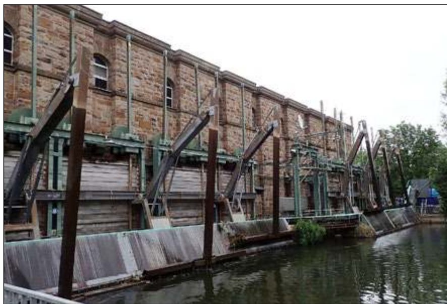
Elektrownia wodna Kahlenberg i ruchome stalowe ramiona ze zgarniaczami do oczyszczania sit Bernikle kanadyjskie nad Ruhrą
