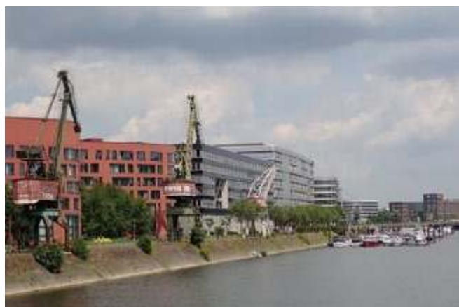
Żurawie portowe wkomponowane w nowoczesną zabudowę
