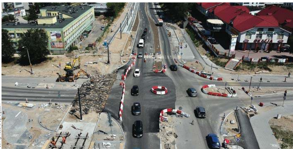
Ulica Wyszyńskiego jeszcze w trakcie budowy nowej linii tramwajowej
