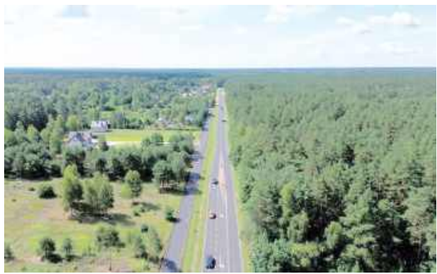
Remont drogi serwisowej w okolicach Frampola kosztował ponad 144 tysiące złotych
