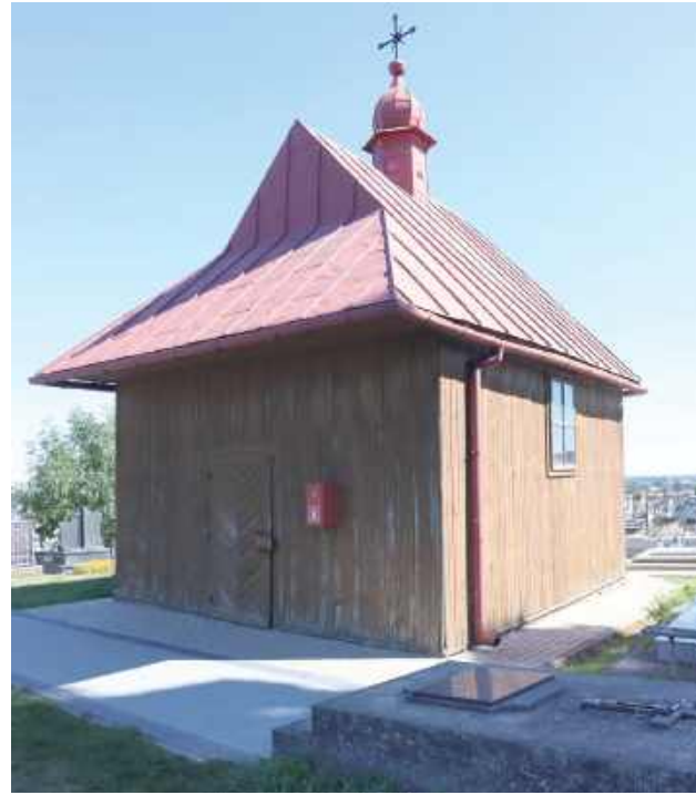
A tak kaplica wyglądała jeszcze niedawno
