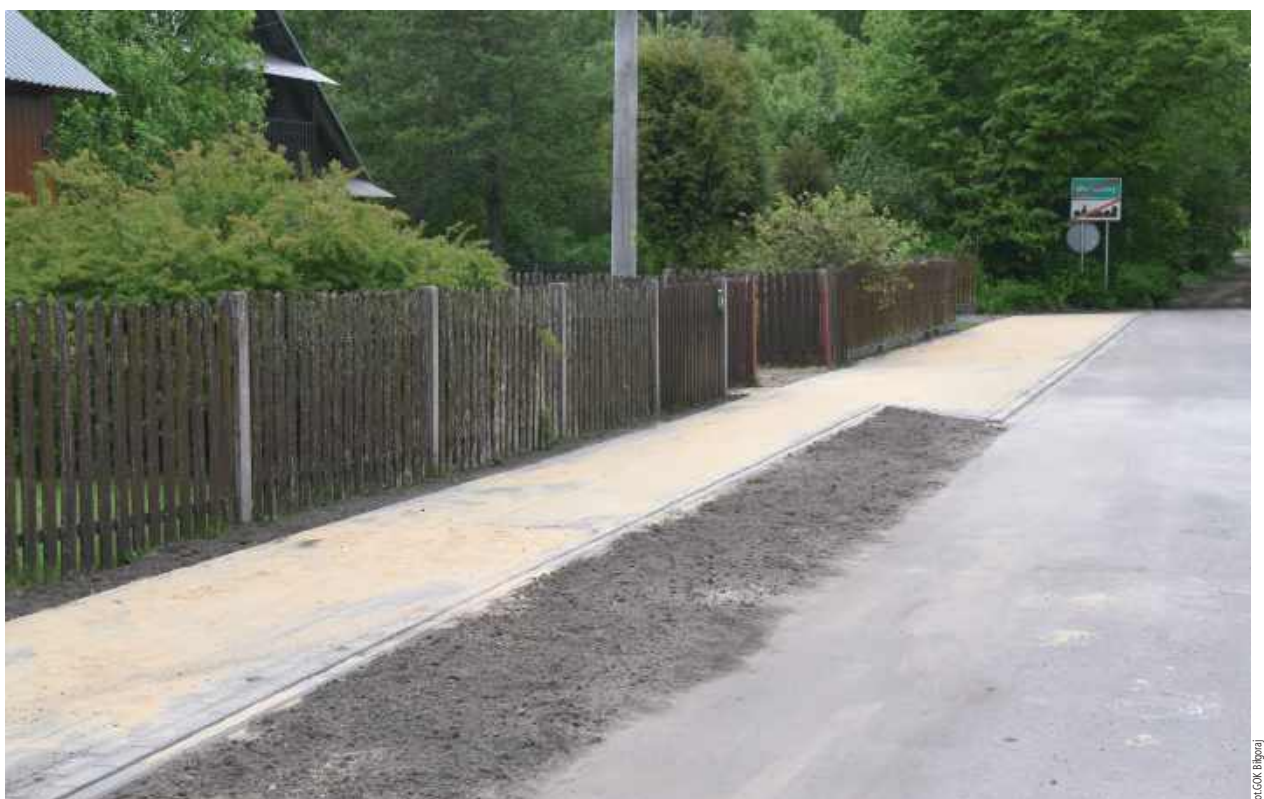
W ramach inwestycji gminy Biłgoraj w Wolaninach powstał chodnik o długości 296,23 metra, który został wybudowany wzdłuż drogi powiatowej nr 2921L
