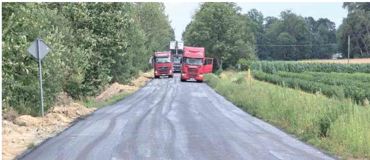
Rozpoczęła się długo oczekiwana modernizacja drogi powiatowej nr 2958L Wola Różaniecka - Różaniec
