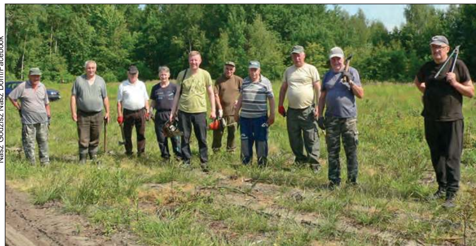
Zanim rozpoczęła się budowa nowego ogrodzenia, należało poprzecinać zarośla i odsłonić granicę działki. Wykonali to we wtorek, 7 czerwca, mieszkańcy Godzisz z sołtysiem Zygmunt Banaszkim na czele
