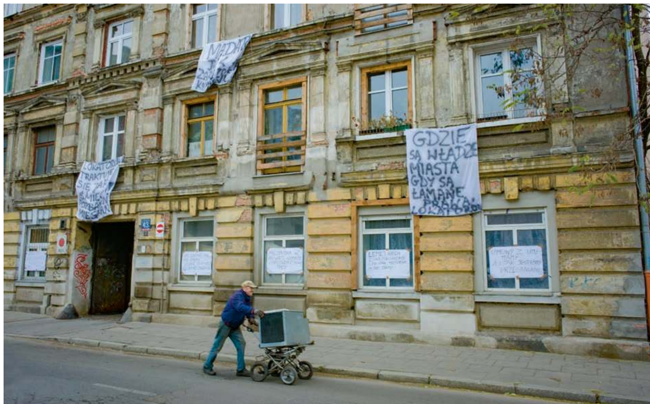
Pękająca kamienica przy ul. Wólczańskiej 43 w Łodzi, listopad 2019 r.
