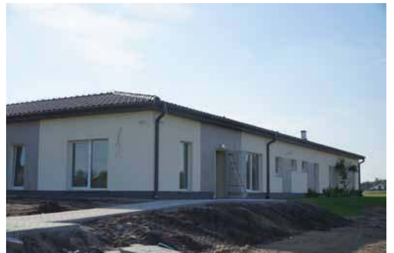
Budowa nowego Centrum Opiekuńczo-Mieszkalnego jest na ukończeniu prac
