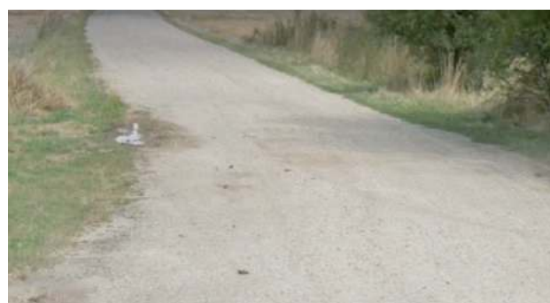
W Stępkowie trakt przypomina raczej wąską dróżkę niż drogę powiatową
