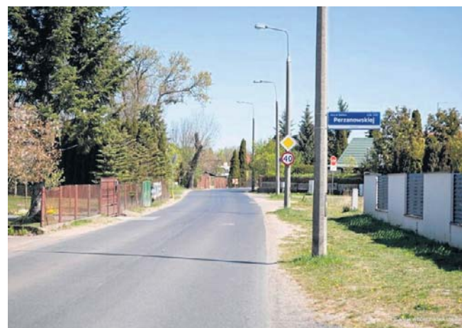
Ulica doktor Stefani Perzanowskiej w Radomiu zostanie gruntownie przebudowana.
